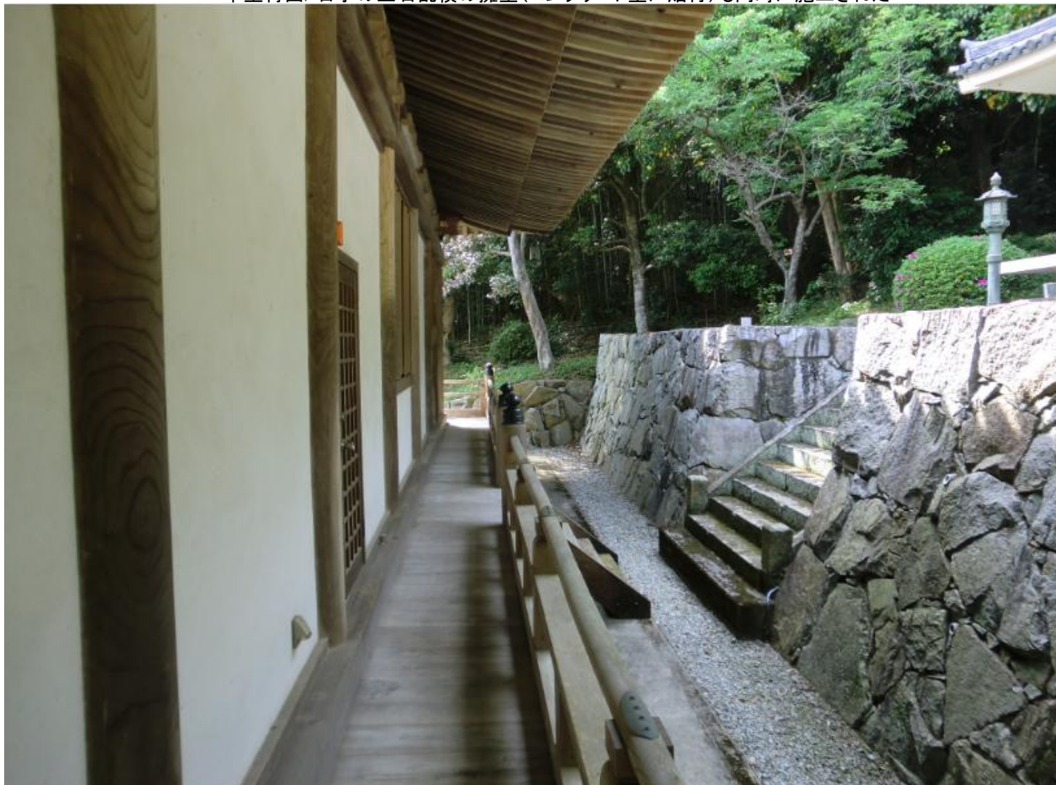
本堂背面/右手の玉石乱積の擁壁(コンクリート壁に貼付)も同時に施工された
